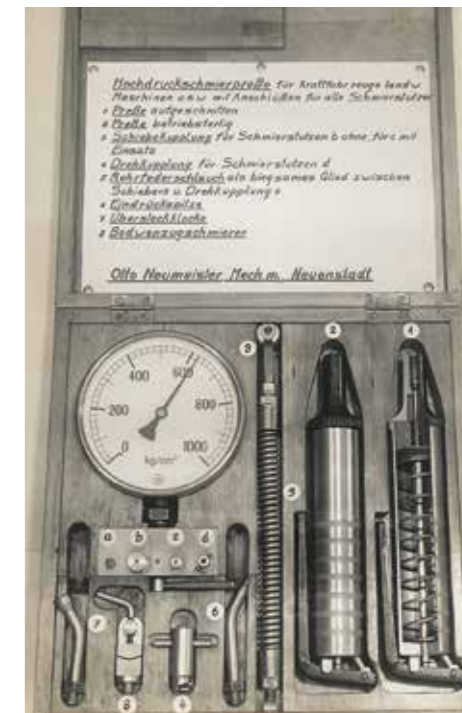
Die Fettpresse „Otto“ war das erste Hydraulikprodukt, dem viele folgen sollten
